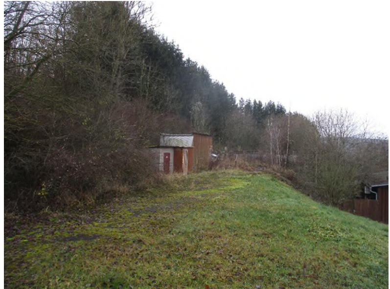
Abbildung 6: schuppenartige, vorhandene Gebäude im Westen des Geltungsbereiches
