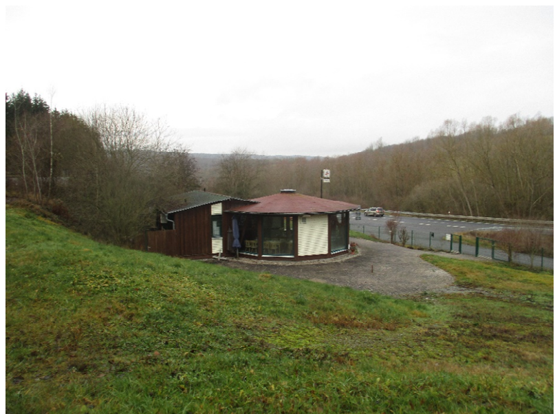
Abbildung 5: Vorhandene Gebäude der ehem. Raststätte
